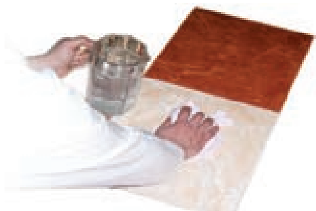
Lavar el suelo con agua.
